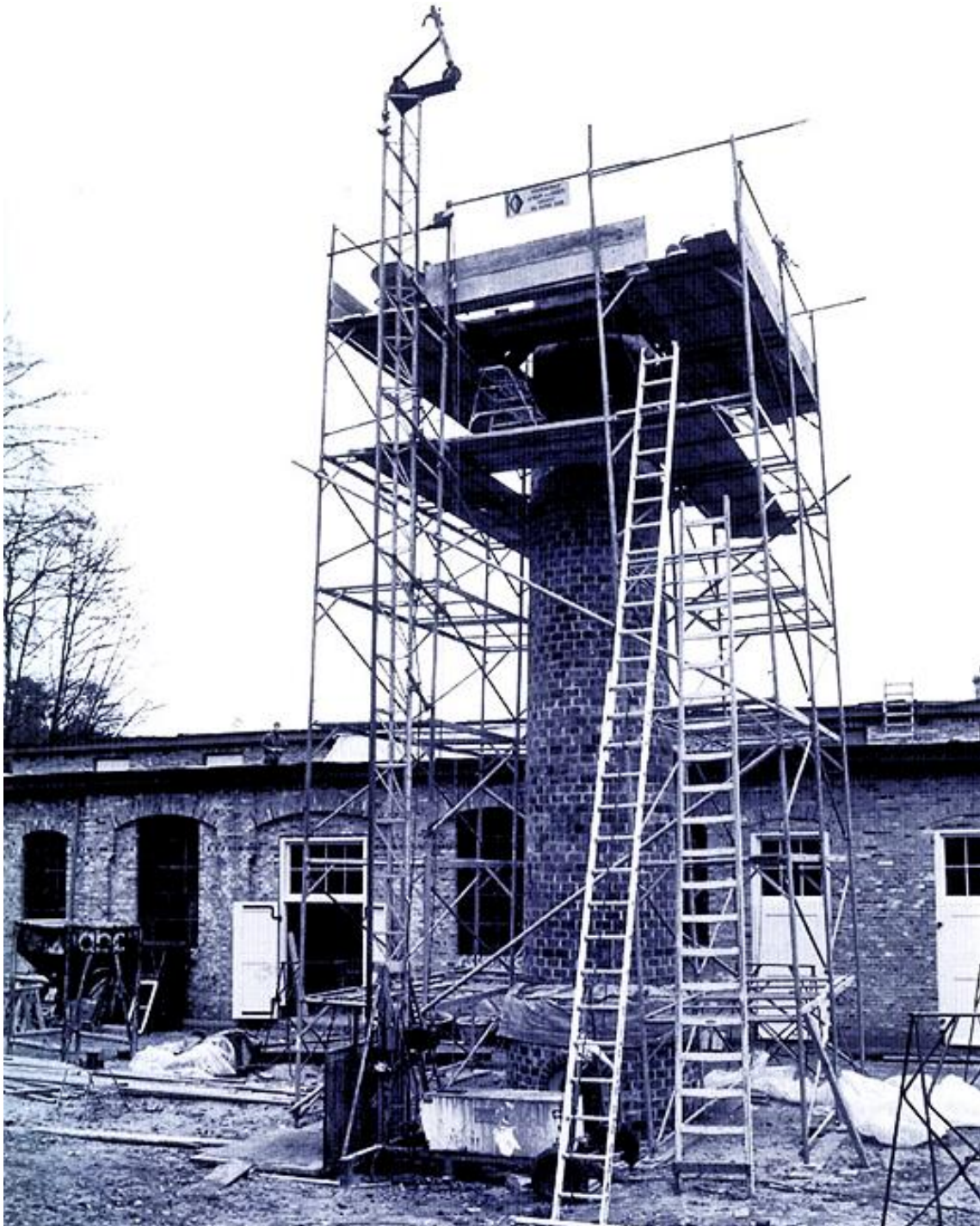
De bouw van de kleinere schoorsteen in het NOM
